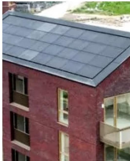
Geïntegreerde zonnepanelen meeontworpen in dakvlak
